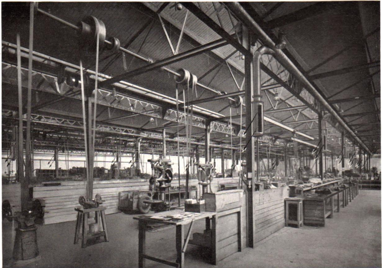
*Chauffage par l'air sous pression d'un atelier de mécanique.*
